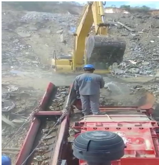
Foto 4- RCC sendo colocado no Britador.
